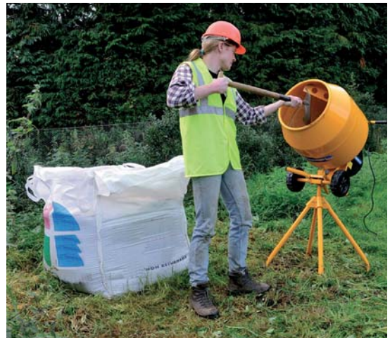
Мешањем песка, цемента и воде добија се бетон.
